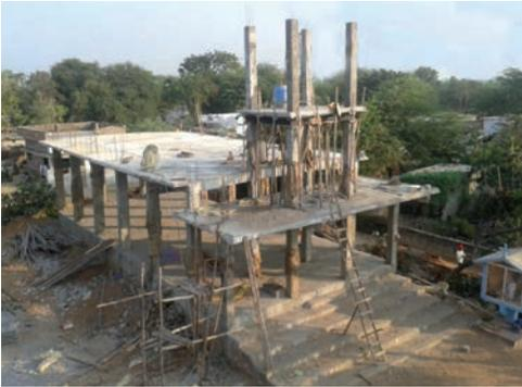
Das 2 m hohe Fundament-Mauerwerk und die 20 Säulen aus Eisenbewehrtem Beton sind aufgebaut. Am 20. Dezember 2016 ist das Portal-Dach und am 31. Dezember 2016 das Kirchen-Dach aus Eisen-bewehrtem Beton abgeschlossen.
